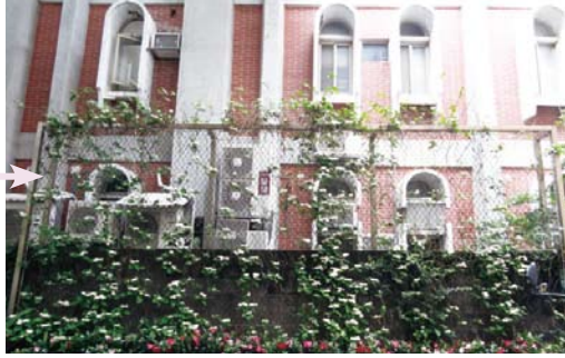
展書樓旁綠牆進行植栽修剪並補植
