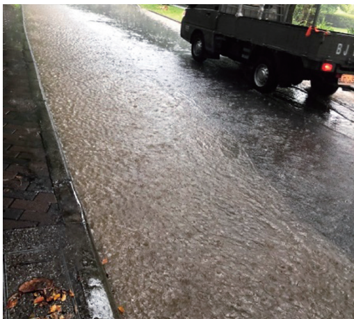
舟山路排水孔蓋覆蓋積水
