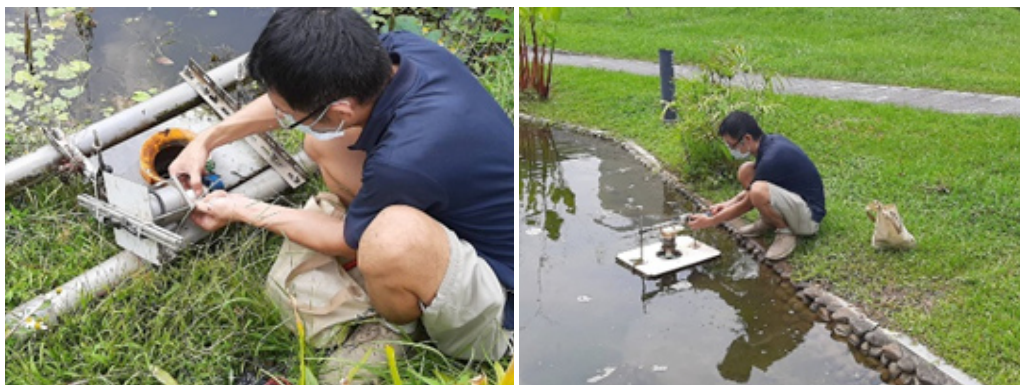
醉月湖中湖及瑠公圳曝氣設備維修情形
