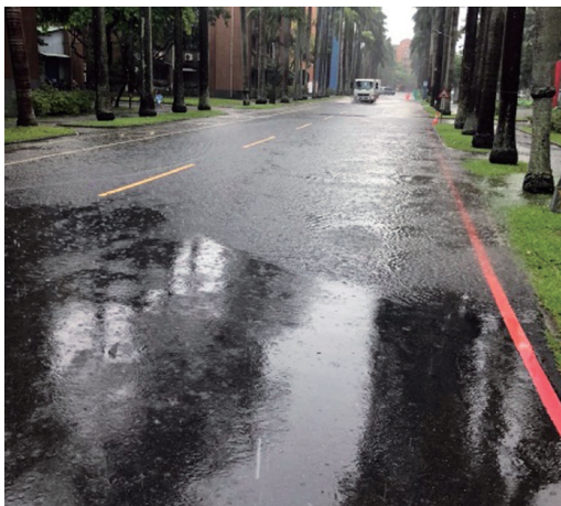
小椰林道排水孔蓋覆蓋積水
