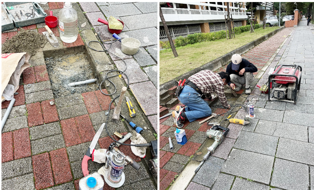
基隆路機車停車場旁漏水修繕
