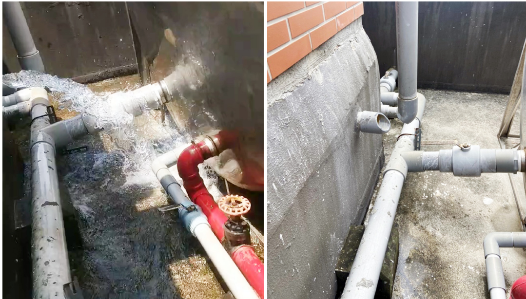
思亮館漏水修繕
