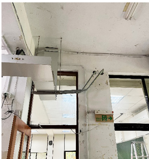
造園館線槽增設
