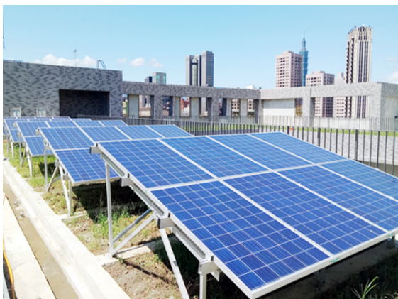
學新館設置太陽能發電設備
