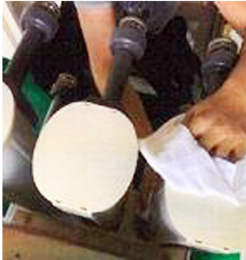
擦拭高壓 VCB
