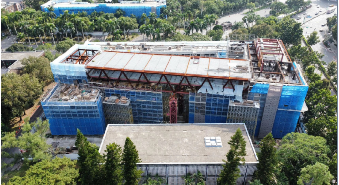
111 年 12 月施工現場空拍照
