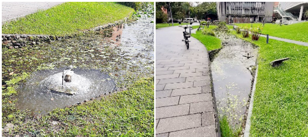
瑠公圳醉月湖段太陽能曝氣設備
