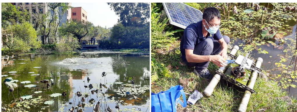
耘水機曝氣設備安裝與運轉情況
