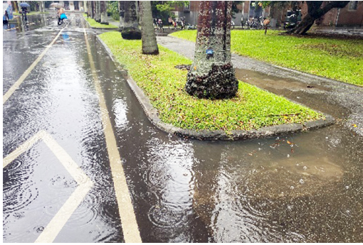
小椰林道排水孔蓋覆蓋積水
