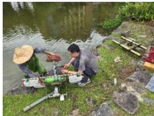
圖 6 瑠公圳醉月湖段及醉月湖中湖，太陽能曝氣設備零件汰換
