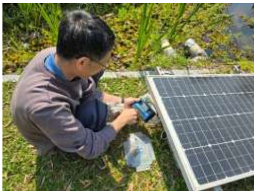
圖 6 瑠公圳醉月湖段及醉月湖中湖，太陽能曝氣設備零件汰換
