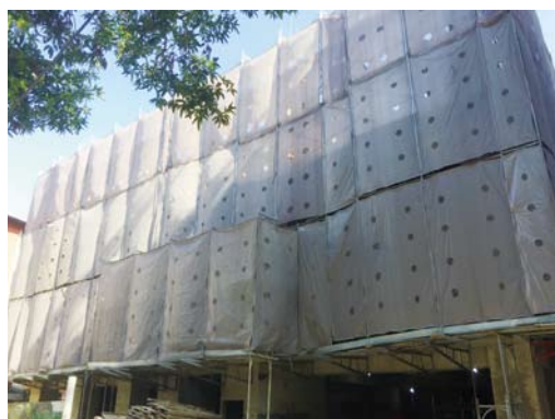
基地二 - 施工外觀
