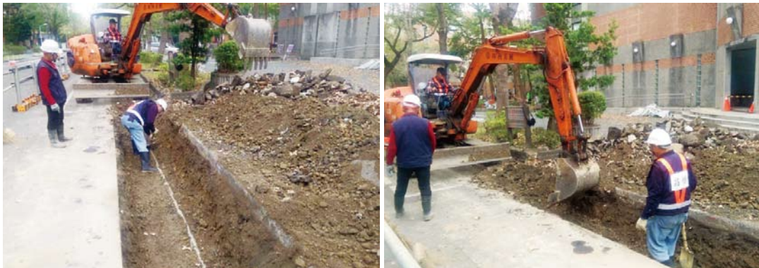
楓香道施工現場
