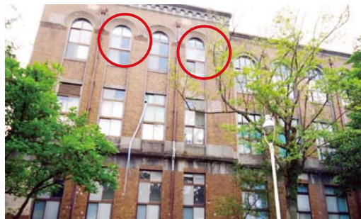
二號館改善後
