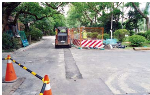
水管埋設後道路先行假鋪
