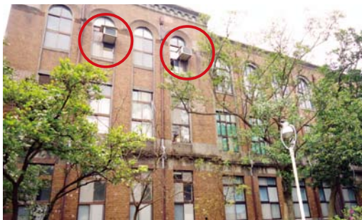
二號館改善前
