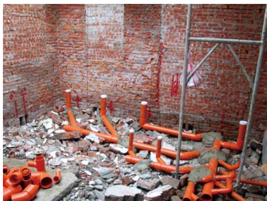
埋設污水管線
