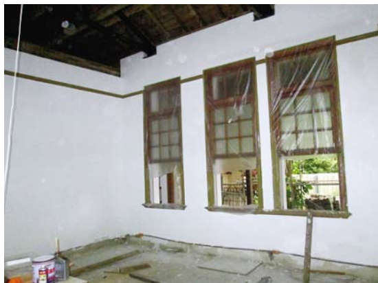
牆壁灰泥重新粉刷與門扇上木漆
