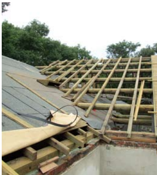
重新鋪設屋面
