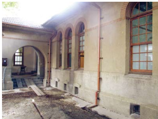
外牆鷹架拆除與牆面清潔
