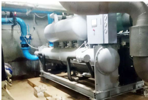
總圖冰水主機更新前
