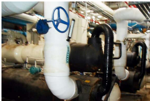
總圖冰水主機更新前
