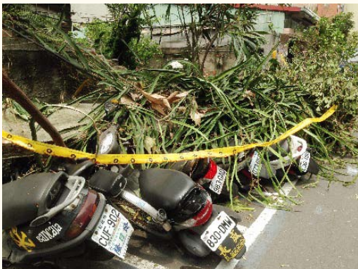
金門街圍牆傾倒
