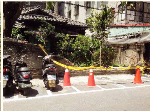
金門街圍牆傾倒清理後
