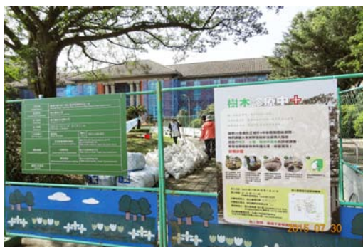
榕樹診斷期間， 特別設置圍籬與告示牌向師生說明
