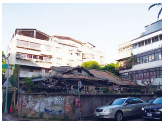
整修前（尚未拆除前）
