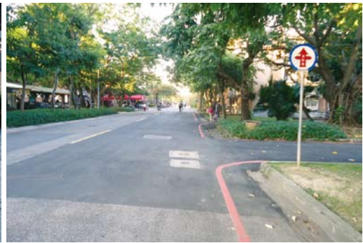
化工館自來水管線更新埋設完工照
