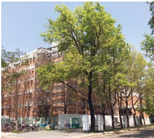
工綜館外牆拆架中
