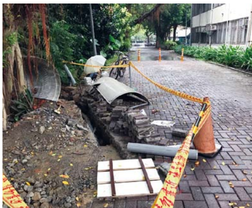
舟山路增設原水取水管
