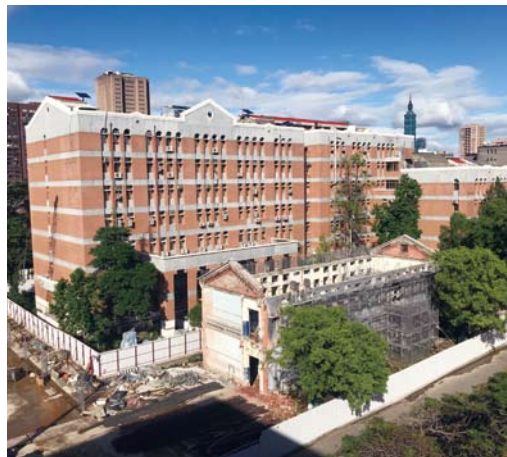
外牆整修後的工綜館， 前方為部分保存的舊機械館
