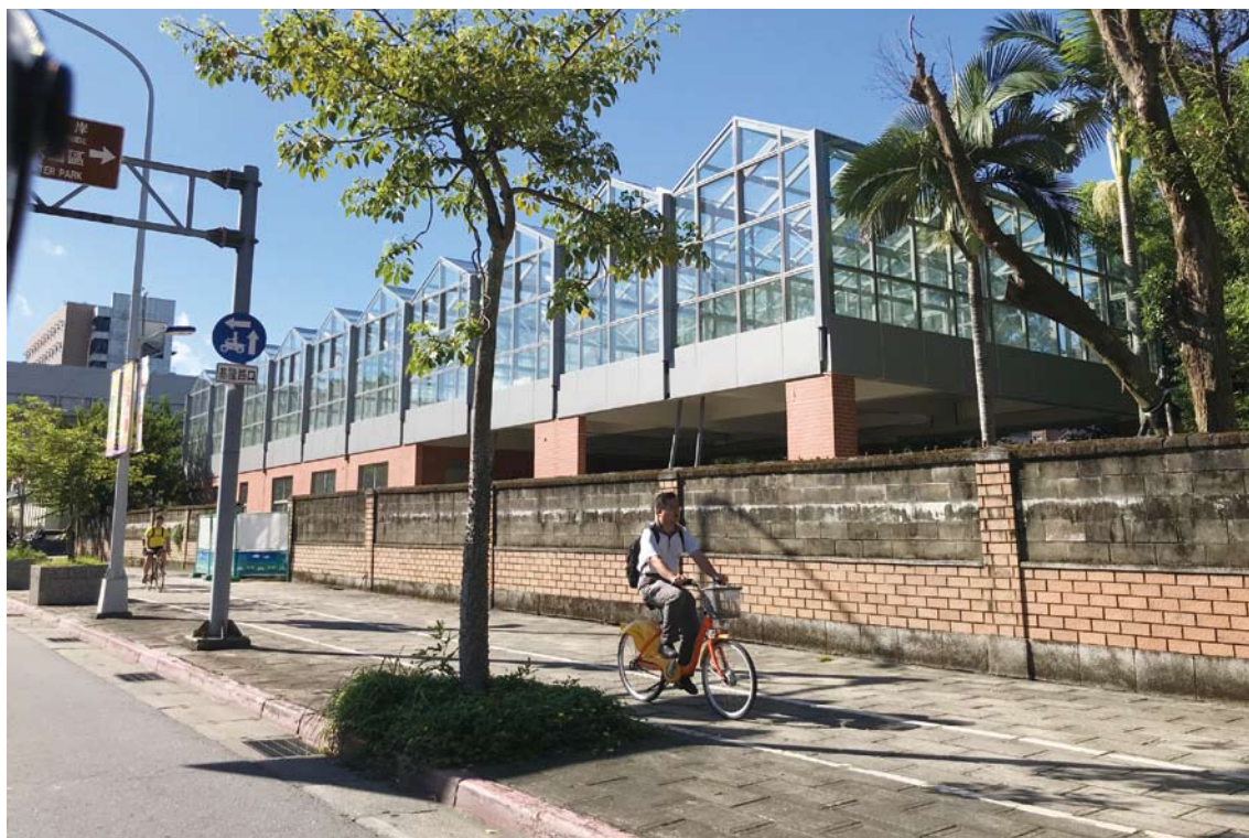
植物培育溫室新建工程施工現場
