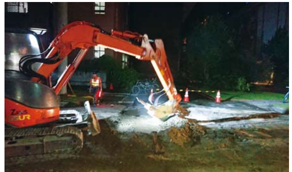
夜間施工情形
