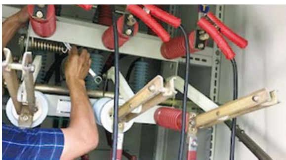
高壓設備停電檢查調整
