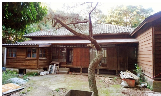
牯嶺街 60 巷 6 號修復現況
