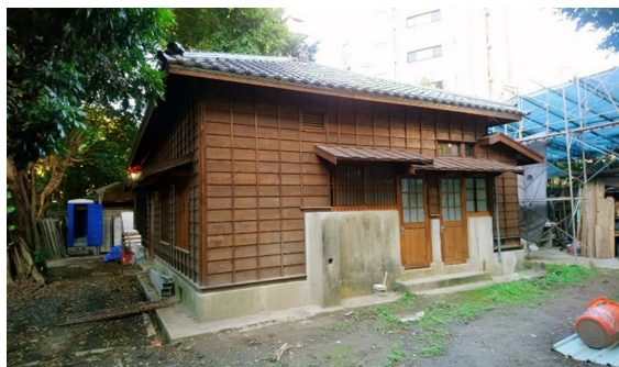
牯嶺街 60 巷 4 號「方東美寓所」修復現況
