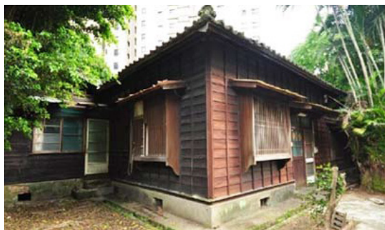
牯嶺街 60 巷 6 號 修復前
