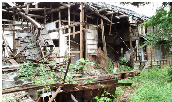
牯嶺街 60 巷 4 號「方東美寓所」修復前
