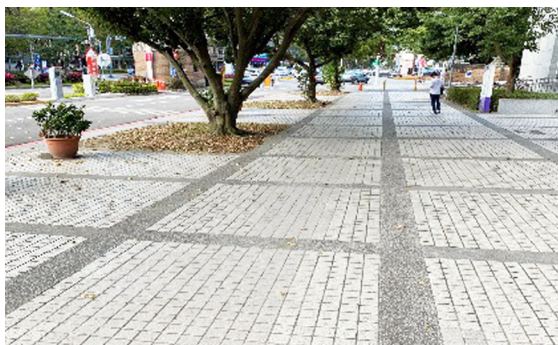
霖澤館自來水管線更新完工照
