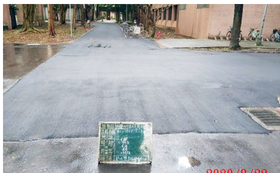
計資中心周圍完工照
