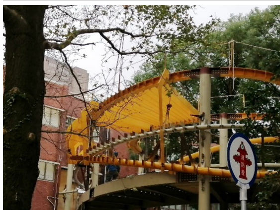
空中走廊鋼構組立
