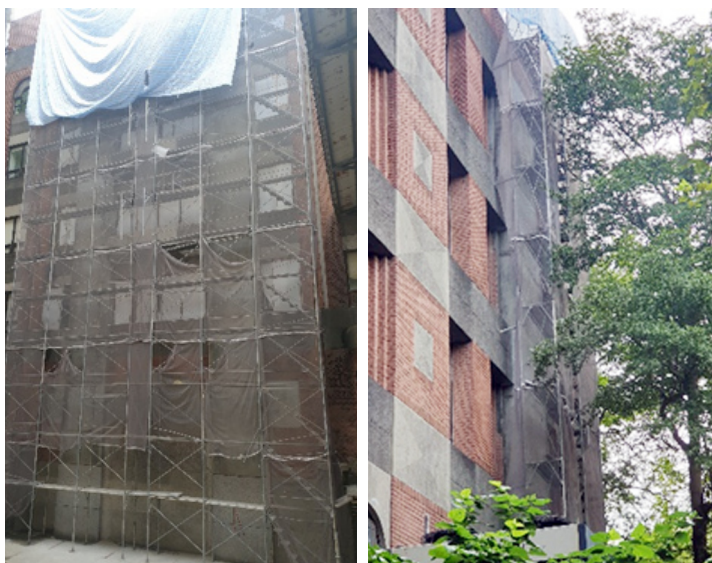
資訊工程館耐震補強工程
