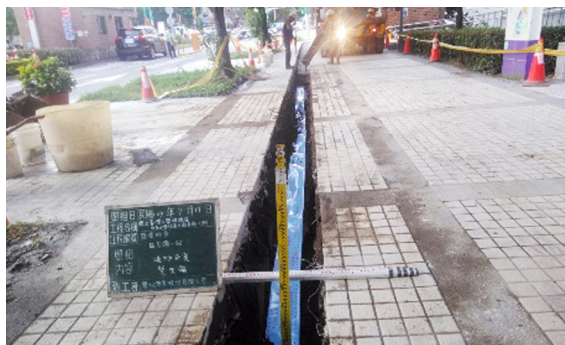
霖澤館自來水管線更新施工照
