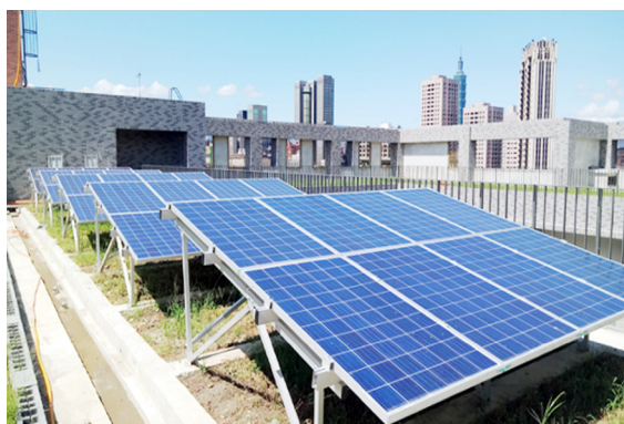
發揚樓設置太陽能發電設備
