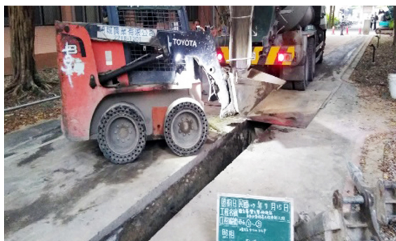
計資中心周圍施工照
