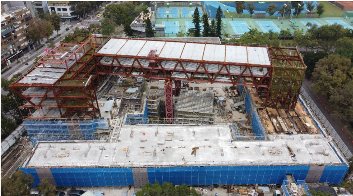
110 年 12 月施工現場空拍照
