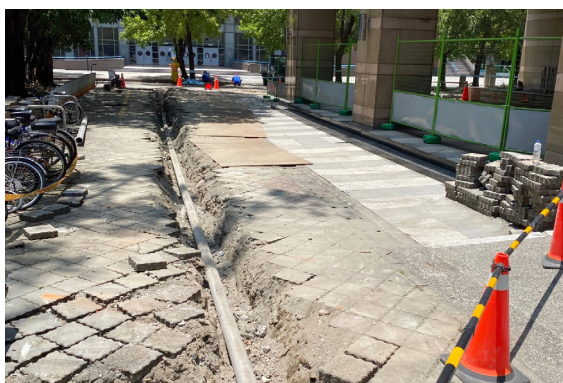
凝態館自來水管線更新施工照
