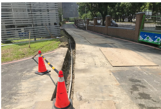
天數館周圍施工照
