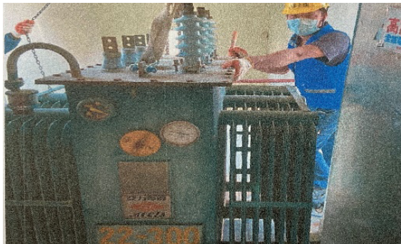
變壓器更新作業
