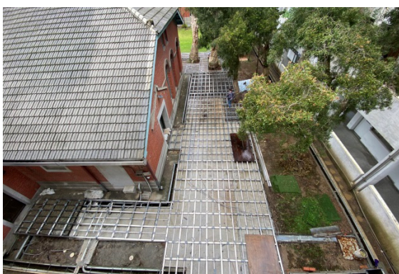
施工中 - 木平台基礎結構
