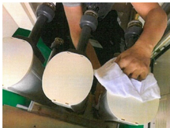
擦拭高壓 VCB
