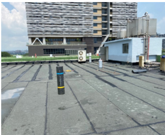
地坪鋪設複合式防水毯
