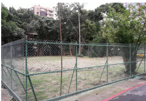
紹興南街 30 巷 6、8、10、14 號施工後
