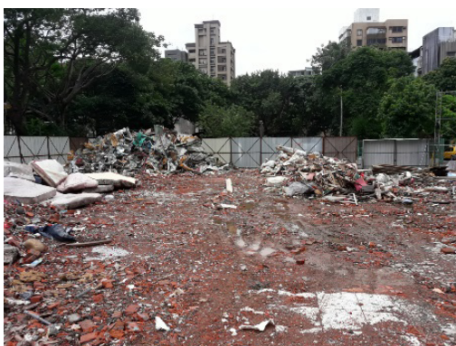
D 區拆除後照片
