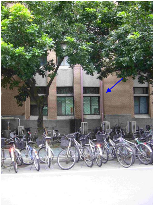
案例三：電機二館南向立面
