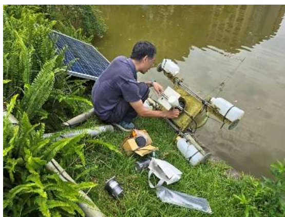
圖 3 醉月湖中湖太陽能曝氣設備零件汰換
