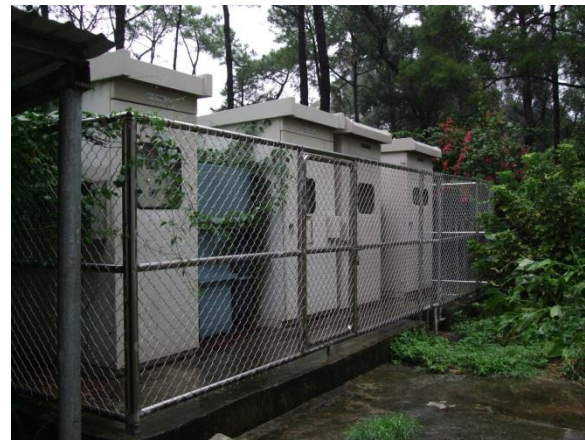
戶外電站—必須先清除戶外電站的爬藤植物
