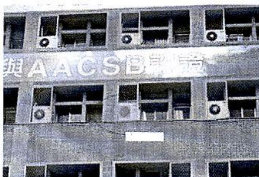
由大草坪方向看二館冷氣室外機：
